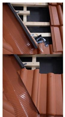
Поролоновые полосы приклеиваются по краю загнутой отбортовки желобка по всей длине ендовы, начиная от аэроэлемента свеса. Защитная полоса удаляется непосредственно перед монтажом.
