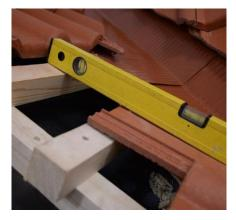
Глубина выемки контролируется правилом. Плоскость подрезанной черепицы должна совпадать с верхней гранью следующей обрешетки.
