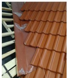
Укладывается рядовая черепица, максимально закрывая желобок ендовы. Предварительно нанесённая разметка на желобке ендовы переносится на черепицу в верхней и нижней точке ендовы.
